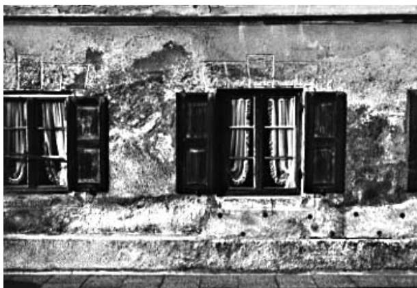
Bild 1: Bauernhaus mit 45 cm dicken Tuffsteinwänden und sichtbar "aufsteigender" Feuchte, gegen die früher schon einmal "Entfeuchtungsröhrchen" eingebaut worden sind. In Wirklichkeit haben Messungen einen erhöhten Salzgehalt im Außenputz ergeben, nach [1].
