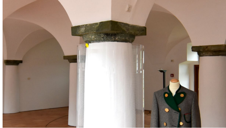
Mikroperforierte schallabsorbierende Säulenverkleidung im Forum Heimat © Fraunhofer IBP
