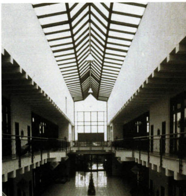
Bild 1: Fotografische Ansicht der Atriumhalle des untersuchten Bürogebäudes.
