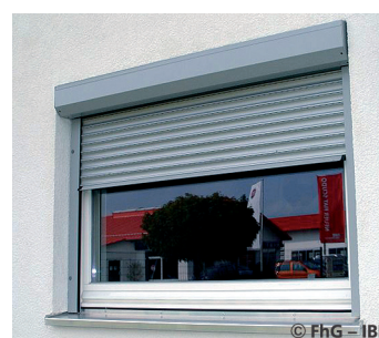
Bild 2: Außenansicht eines halb geöffneten Rollladens
