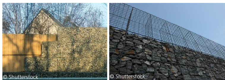
Bild 4: Links: Lärmschutzwand aus Gabionen mit dahinterliegendem, schalldämmendem Betonkern; Rechts: Wand aus Gabionen während der Bauphase.
