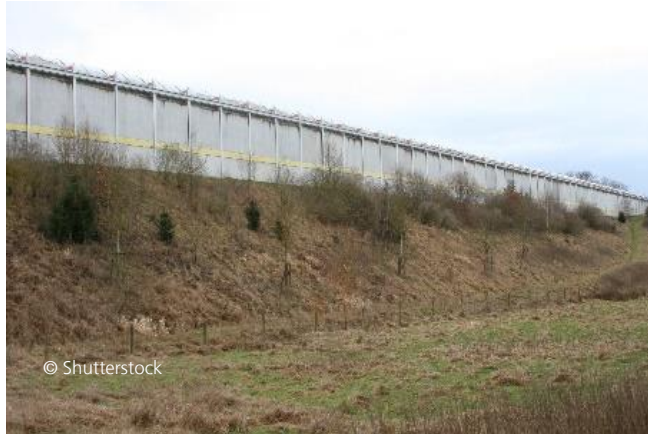
Bild 3: Erdwall mit aufgesetzter Lärmschutzwand.
