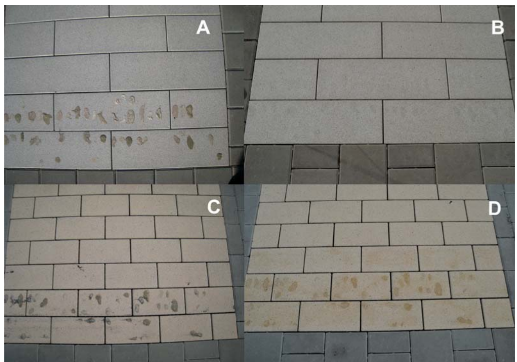
Bild 2.7: Sektion mit Kaugummiverschmutzung einer beschichteten Testfläche vor (A) und nach (B) bzw. einer unbeschichteten Testfläche vor (C) und nach (D) der händischen Abreinigung mittels Hochtemperatur-Hochdruck-Reiniger.
