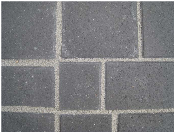
Bild 3.15: Keine Risse in der Kunstharz basierten Fuge detektierbar.
