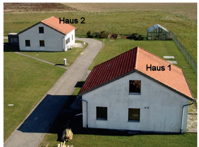
Bild 1. Nach Westen ausgerichtete Giebelseiten der identisch aufgebauten Versuchs-Häuser vor Aufbringung der untersuchten Beschichtungen
