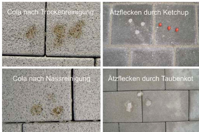
Bild 11. Hartnäckige Flecken von Cola nach Reinigung (links) und Ätzflecken durch Ketchup und Taubenkot (rechts).
