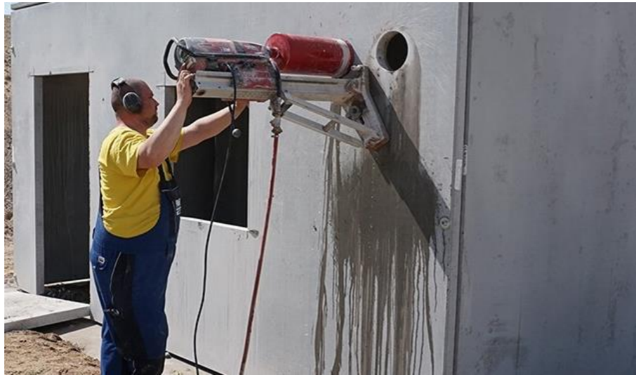
Abb. 1 bis Abb. 3: Abbruch von Bauwerken aus Carbonbeton
